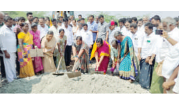
రోడ్డు గుంతలు పూడ్చే పనులు ప్రారంభిస్తున్న ఎమ్మెల్యే పరిటాల సునీత
